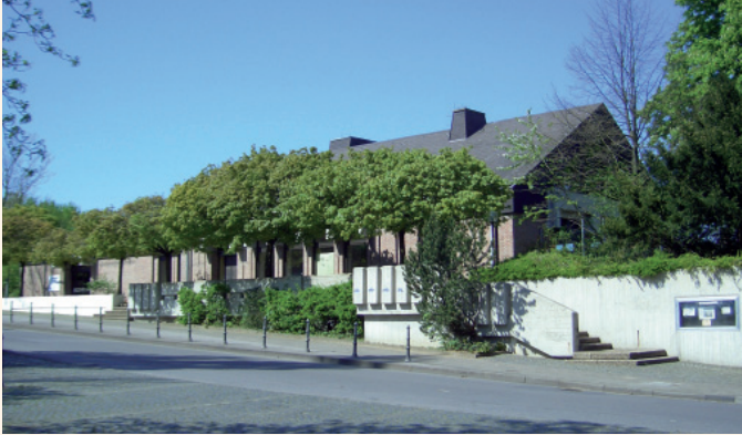
Das Sandhäuschen von der Laurentiusstraße aus gesehen
